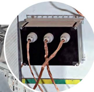
▲ Такие коробки заземления помогут решить задачу безопасного разземления кабельных линий
