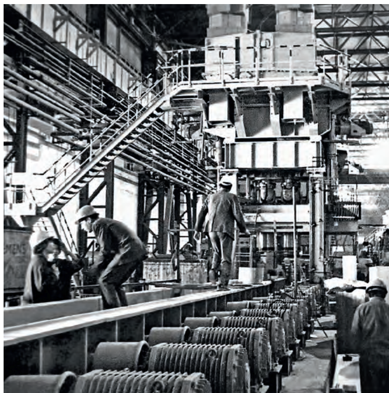
▲ Сентябрь 1986 года. Монтаж и наладка вспомогательного оборудования первой группы непрерывно-заготовочного стана-700
