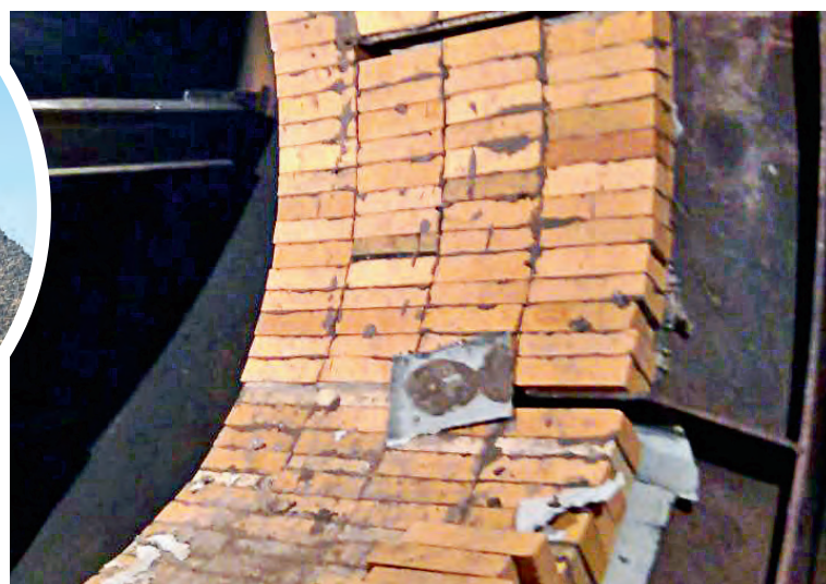
▲ Во время отделки барабанной сушилки некоторые кирпичи нужно подрезать с высокой точностью и соединять друг с другом под разными углами наклона. Тонкая работа!
