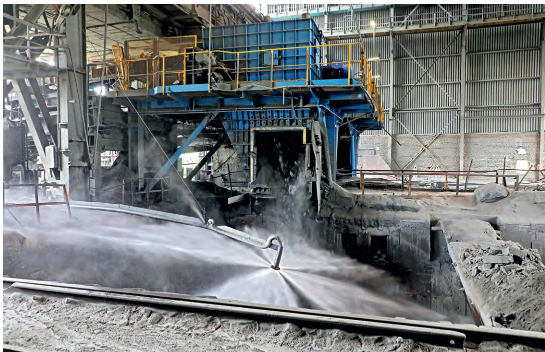
▲ Дробильщик активирует систему пылеподавления с интервалом в две минуты — примерно столько нужно, чтобы разгрузить один думпкар железнодорожного состава
