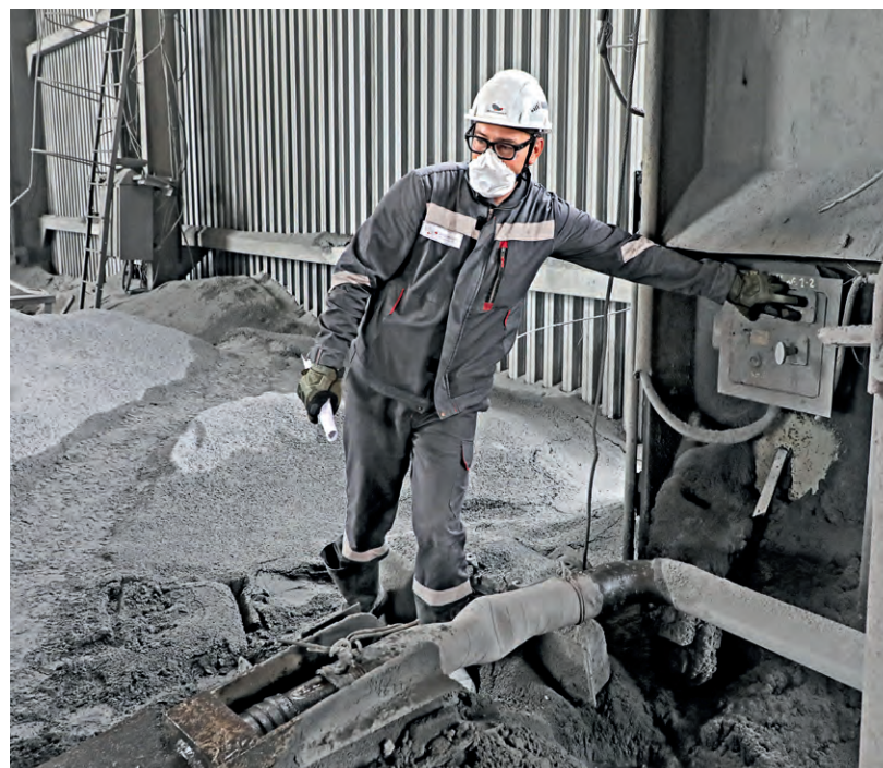
▲ Данил Карлин и его коллега предложили улучшить конструкцию системы пылеподавления и исключить применение гофротрубы
