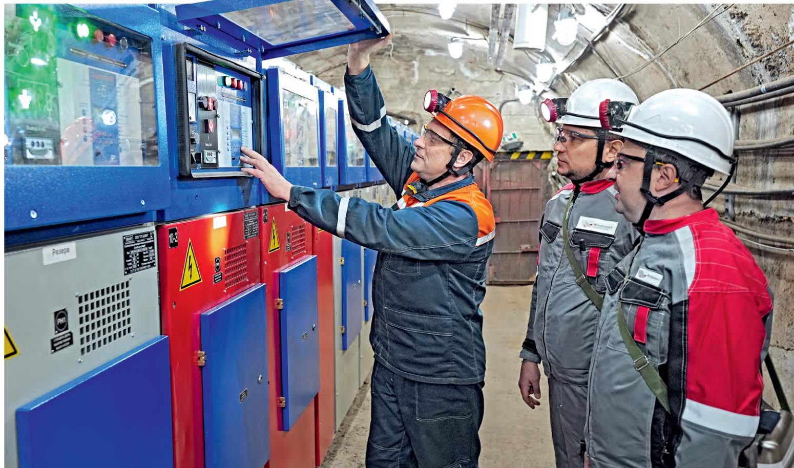
▲ Устройство защиты «Сириус», которым оснащены новые ячейки, позволяет мгновенно отключать неисправные участки. И тем самым сохранять смежные агрегаты!
