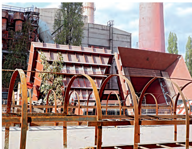
▲ Специалисты монтируют корпуса электрофильтров
