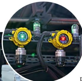
◀ Датчики замеряют уровень загазованности в разных точках цеха и в режиме реального времени передают информацию на контроллер
