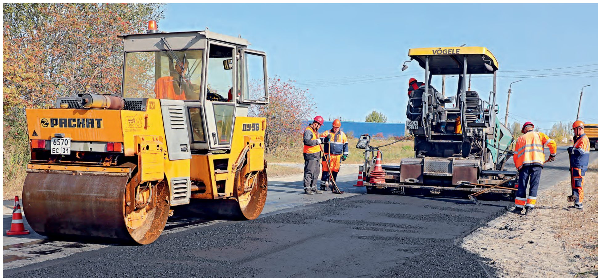
▲ При капитальном ремонте важно грамотно выполнить все этапы работы — от демонтажа старого покрытия до финишной отделки
